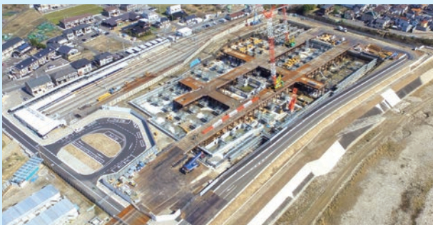
工事の様子2月19日
